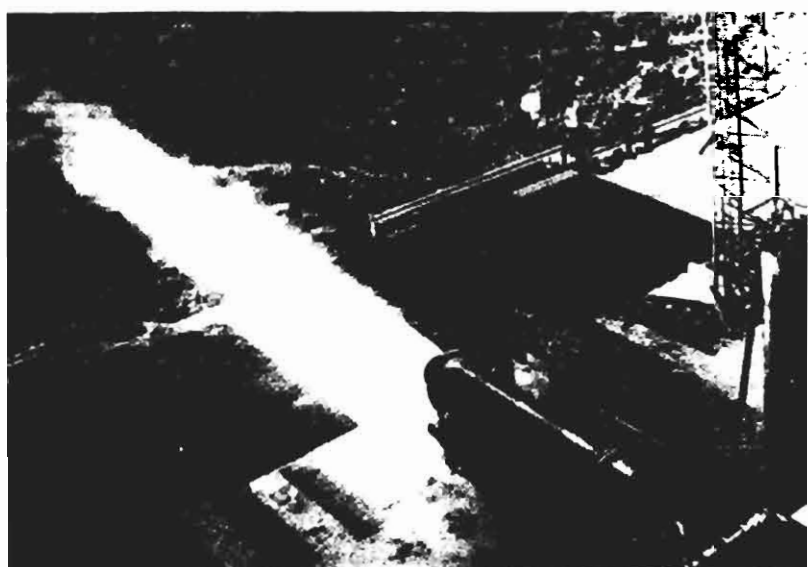
310kN-H* 固液混合火箭发动机地面试车 (美国)
