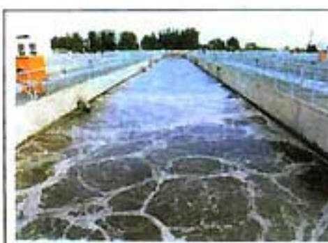
曝气池：通过微生物的代谢作用，将污水中各种复杂的有机污染物降解为简单的、无害的物质
