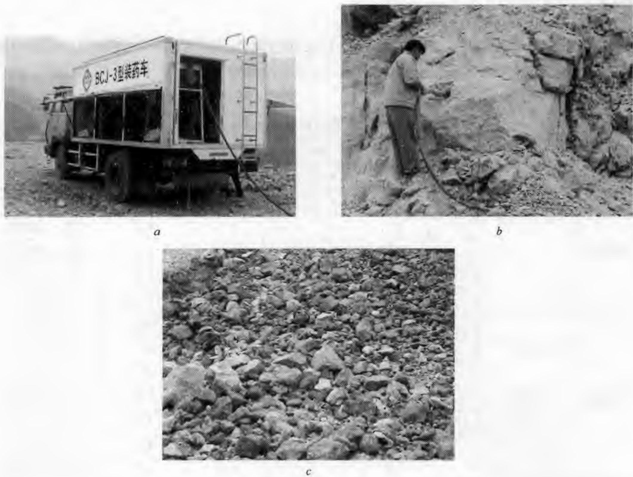
图 10-59 BCJ-3 型乳化炸药现场混装车在采石场的应用 a—装药车在现场；b—装药过程；c—爆后石料
