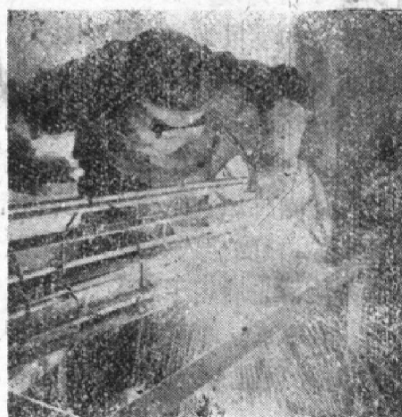
电焊骨架
