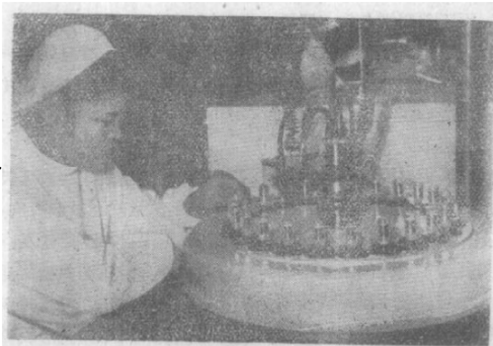
圖18-8 蒸散吸气剂。
