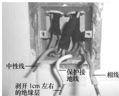
图 6-104 分出中性线、相线、保护接地线，剥开 1cm 左右绝缘层
