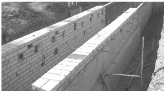
图 5-16 砌筑好的电缆沟
