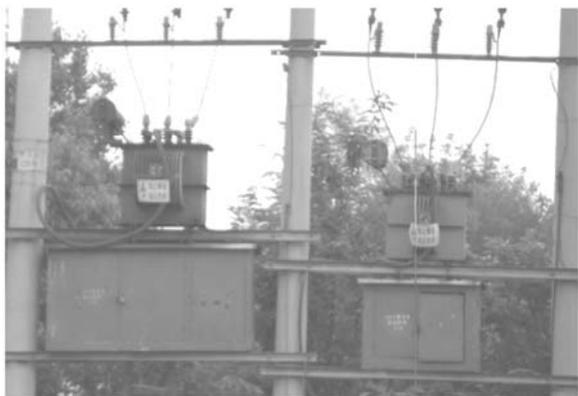
图 3-14 运行中的双杆台架式变压器台
