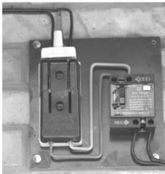
图 9-10 单相漏电保护器的安装
