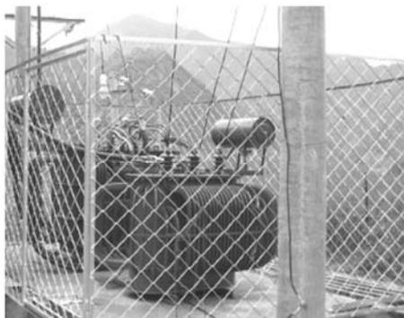
图 3-17 落地式变压器台
