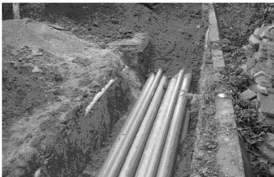
图 5-14 电缆沟回填土施工现场
