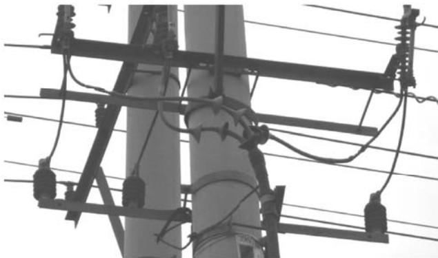
图 5-28 安装在室外的电缆头
