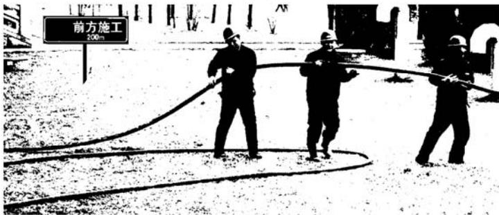
图 5-10 人工展放电缆施工现场
