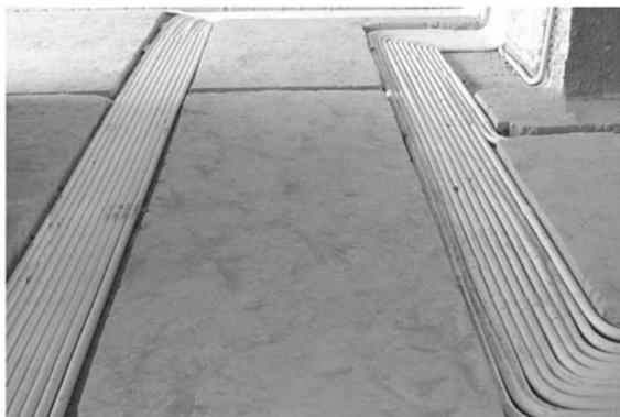
图 6-29 电线管必须敷设紧密、接口密封良好
