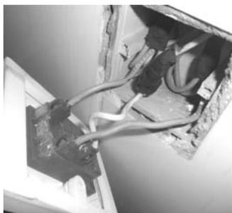
图 6-105 按要求压接导线
