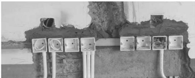
图 6-27 配合土建工程预埋好的暗线管路件
