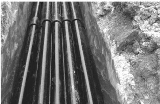
图 5-8 埋设电缆保护管的施工
