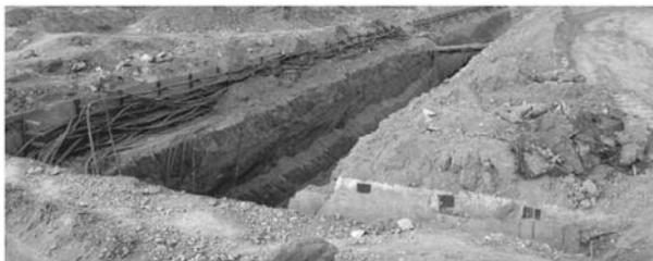
图 5-7 挖掘好的电缆沟
