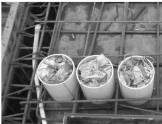
图 6-43 用水泥纸袋堵塞电线管路口
