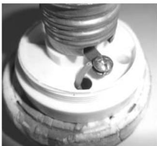
图 6-88 将电源线正确地压接在灯头盒上
