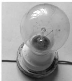
图 6-91 安装白炽灯，检查合格后通电试灯
