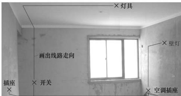
图 6-2 室内布线的定位、画线
