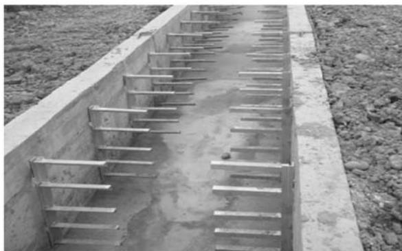
图 5-5 施工中的电缆支架、托臂
