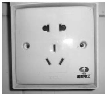
图 6-106 将插座固定在墙上
