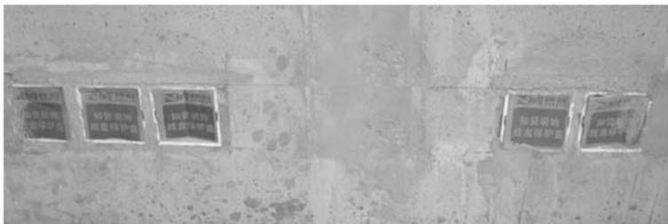
图 6-28 预埋好的管路件口应封堵严实
