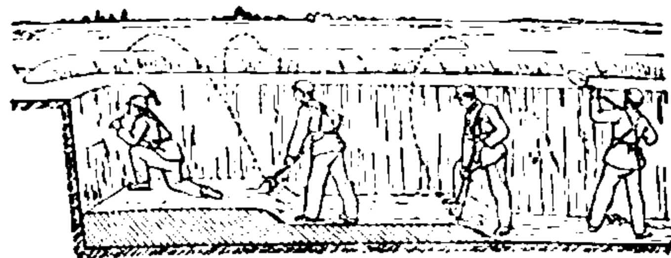
图29 用近迫作业法构筑堑壕和交通壕
